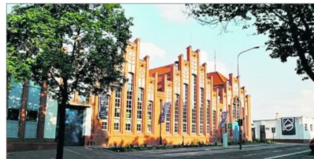
Odnowiona Przepompownia Ścieków w Poznaniu
